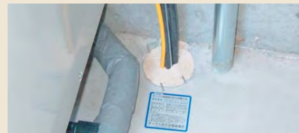
PS060FL-0113工法 施工例
