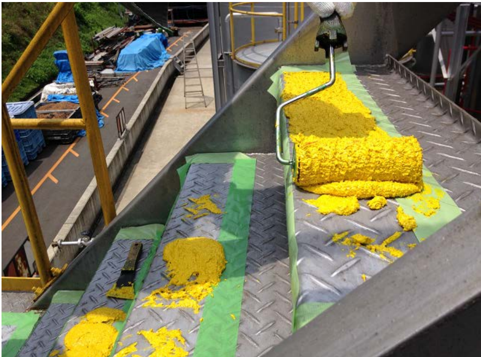
[写真-5] 塗布方法； 任意の量を塗布面に置く。 次に、専用ローラーで樹脂を 塗り広げてゆく。
